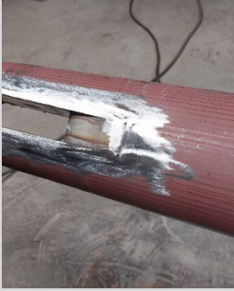
Figuur 2 Aanbrengen Valbescherming
